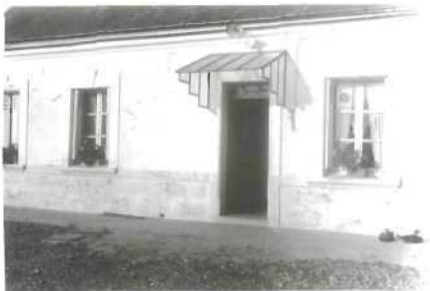
(cliché n° 2) façade de l'habitation avant d'être photographiée et observée.
