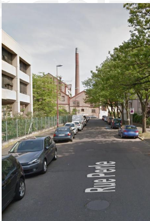
Cheminée de la Brasserie Schutzenberger. (Vue depuis la rue Perle à Strasbourg)
